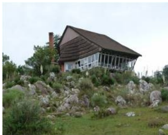
Foto 16 _ Ventorrillo de la Buena Vista
